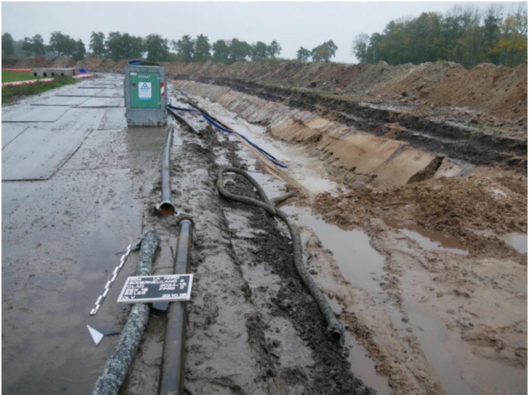
Der Kabelgraben der 320-kV-Gleichstromleitung DolWin4 bei Süderneuland II. Trotz wasserhaltender Maßnahmen mussten selbst im Bereich der wasserdurchlässigen Sandböden der ostfriesischen Geest die Bauarbeiten zeitweise eingestellt werden.
